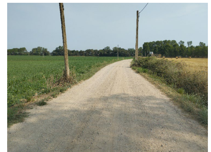
Camí d'accés als recinte per on passarà la línia d'evacuació
